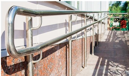
при подъеме по пандусу обеспечивают специальные перила (для инвалидов), которые служат при необходимости опорой. Чаще всего используются перила из нержавеющей стали, которые имеют высокую стойкость к коррозии и не требуют специального ухода (покраска). Перила для инвалидов изготавливаются с учетом технических
